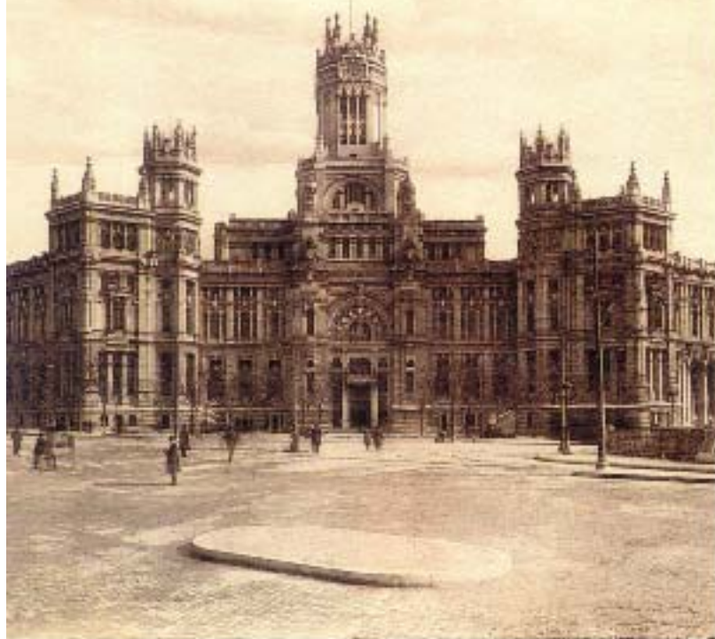
CATEDRAL CIVIL. El Palacio de Comunicaciones se inauguró en 1918. 'Nuestra Señora de las Comunicaciones' fue la obra con la que Palacios despuntó como arquitecto.
